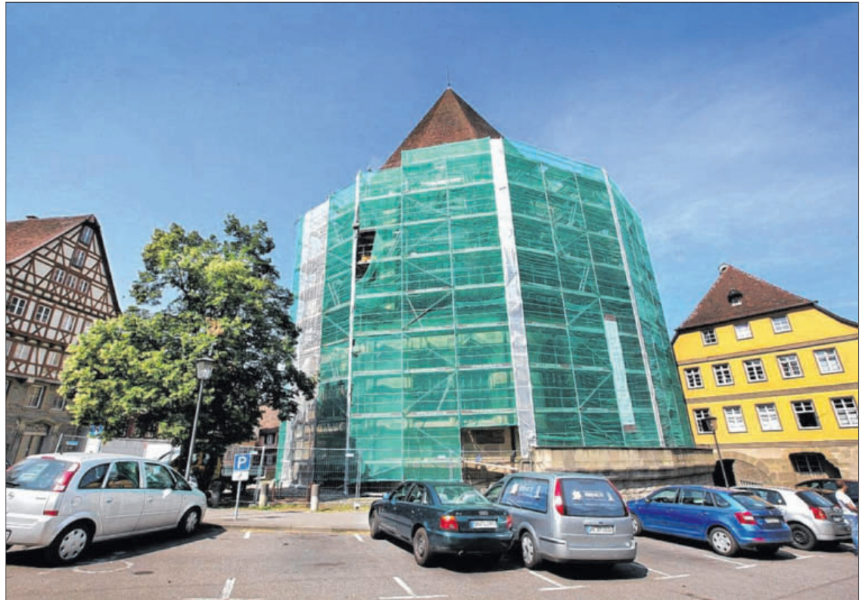
Die Außenseite des Chors der St. Michaelskirche versteckt sich hinter einem Gerüst. Derzeit werden dort vor allem die Fugen an der Fassade erneuert. Kosten: rund 450 000 Euro. Die Kirchengemeinde muss davon 30 000 Euro aufbringen. Foto: Ufuk Arslan
