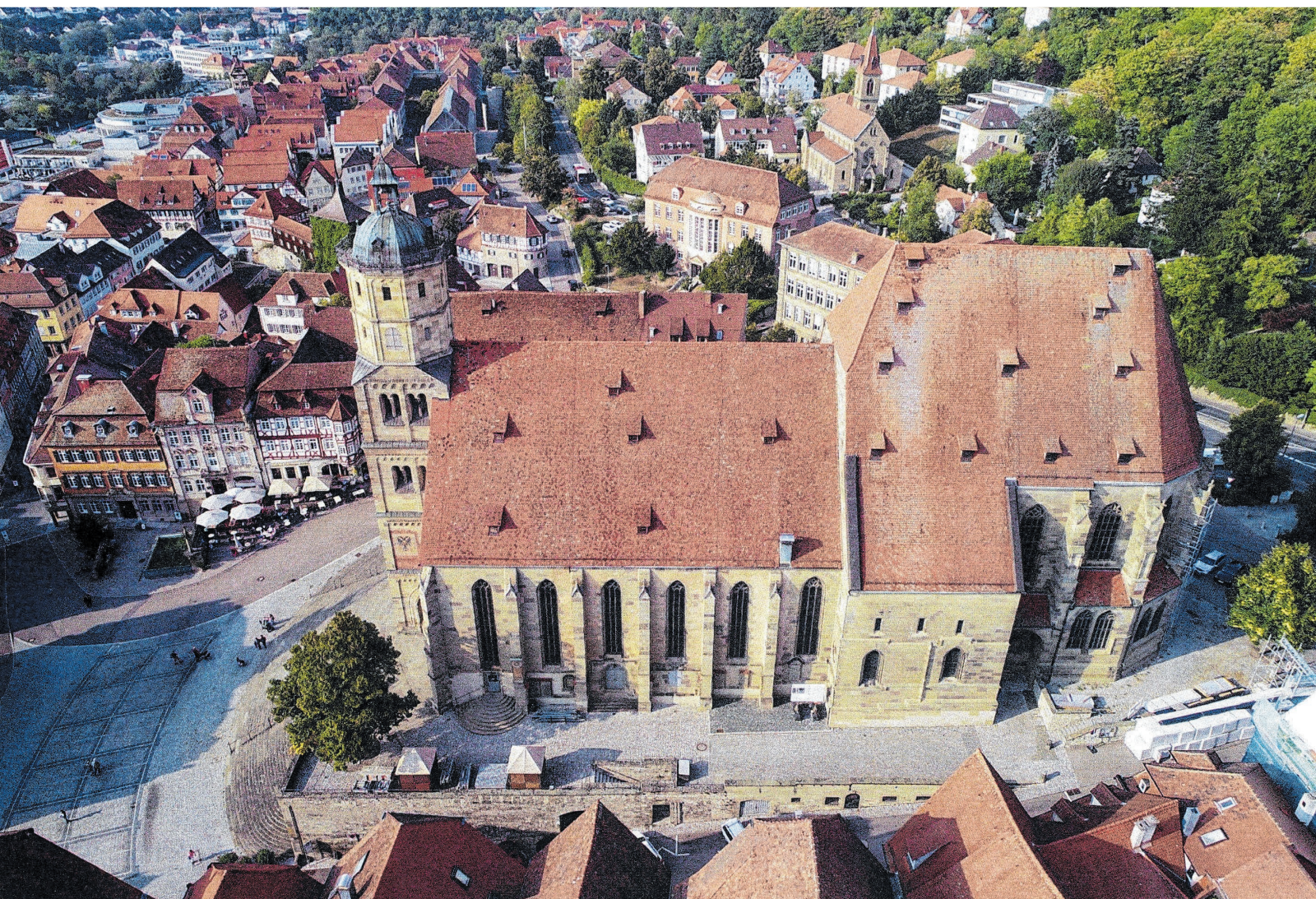
Die Südseite der Michaelskirche soll einen barrierefreien Zugang erhalten. Dort gibt es drei Türen, die dafür in Frage kommen: Eine mit runder Treppe davor (links), eine in der Mitte und das Brauttor (rechts, leicht verdeckt). Foto: Architekt Beck
