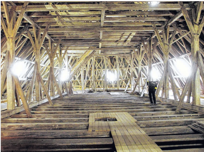
Ein Putztrupp der Firma Kärcher reinigt im Jahr 2009 den Dachstuhl der Kirche St. Michael. Vor 500 Jahren hat ein Zimmermann aus Waldenburgh den Auftrag erhalten, die Balken einzusetzen.
